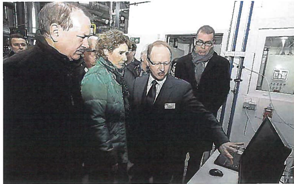
Christoph Zeis, Geschäftsführer der Nahwärmeversorgung Birkenfeld GmbH (2. von rechts), erläuterte Ministerin Eveline Lemke und den Eröffnungsgästen die Funktionen der neuen Heizzentrale.
