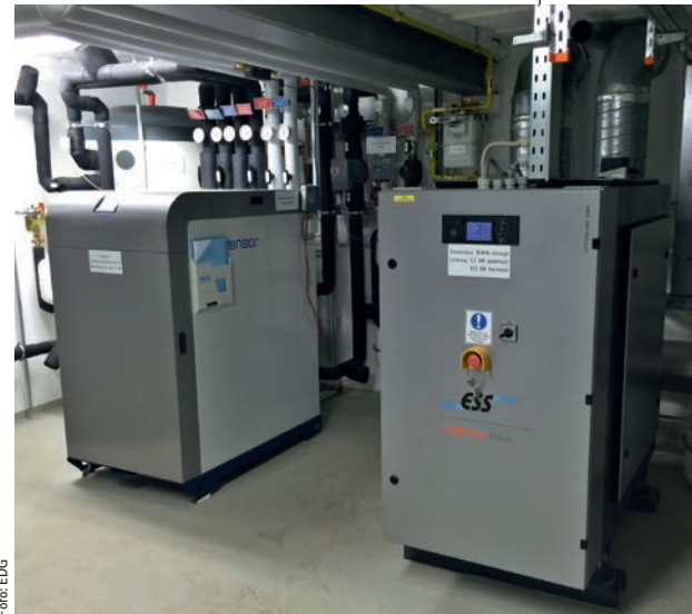
Kraft-Wärme-Kälte-Kopplung, Weingut Osthofen
