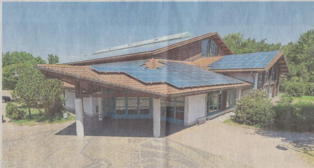
Die Petersberghalle soll an das neue Nahwärmenetz angeschlossen werden. Foto: photoagenten/Carsten Selak
