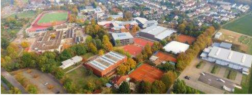
Luftbild Schulzentrum Nieder-Olm, Bild: EDG
